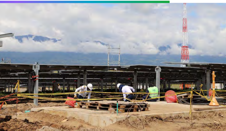
Construcción Parque Solar Brisas
