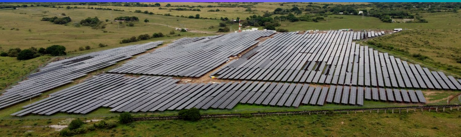
Las Brisas Plant
